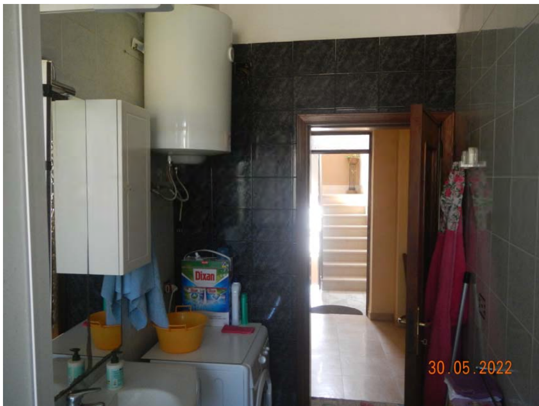
Bagno: foto verso la porta d'ingresso / vano scale.
