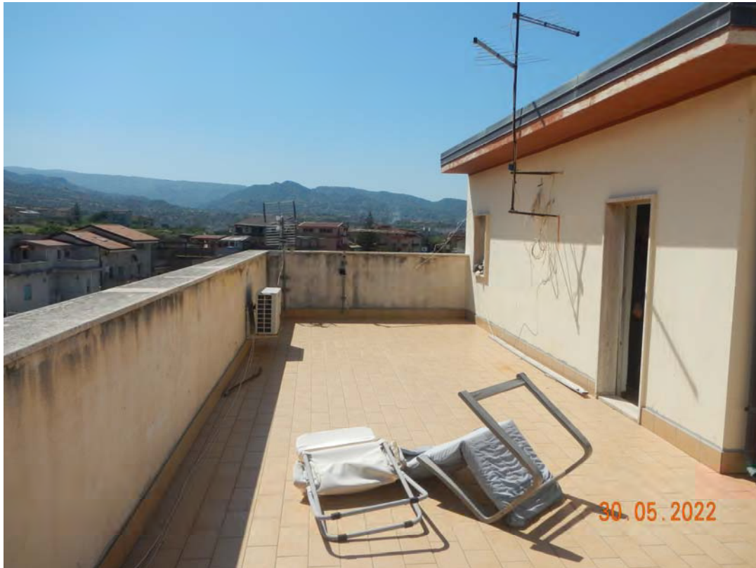
Uscita sul terrazzo - pavimentazione
