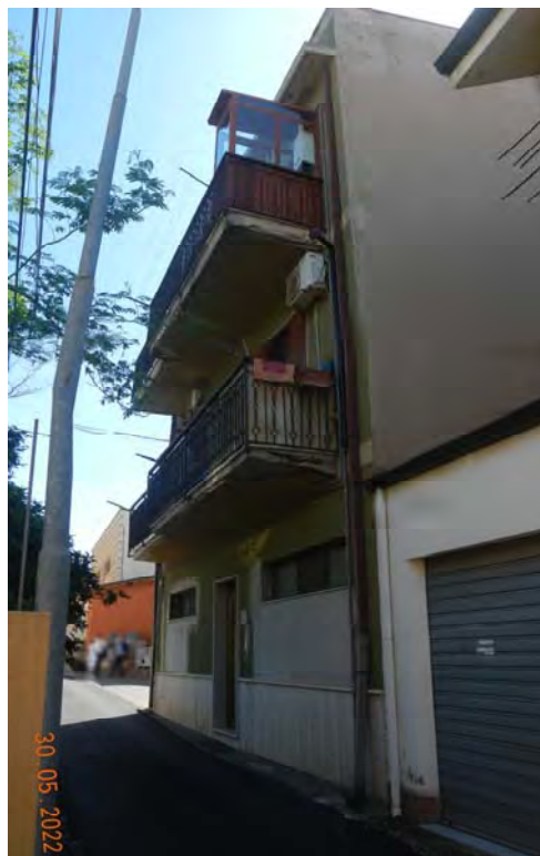
Prospetto prospiciente la strada di Via Patera
