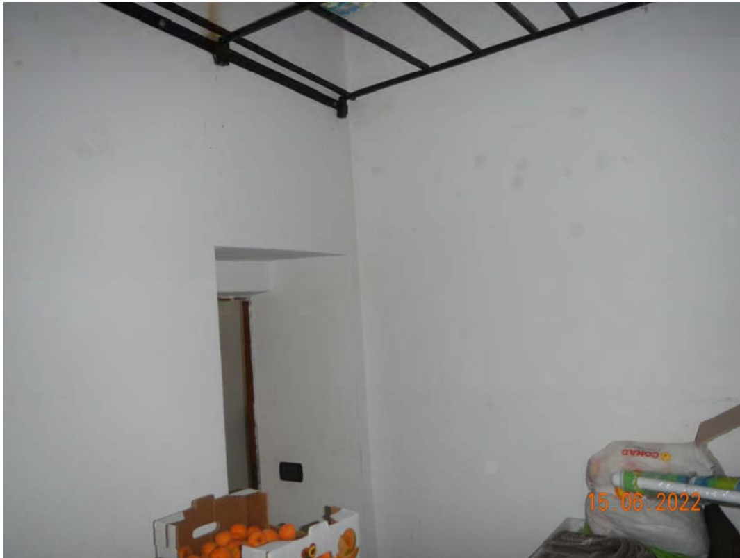
Stanza lungo il corridoio con porta (a sinistra)
