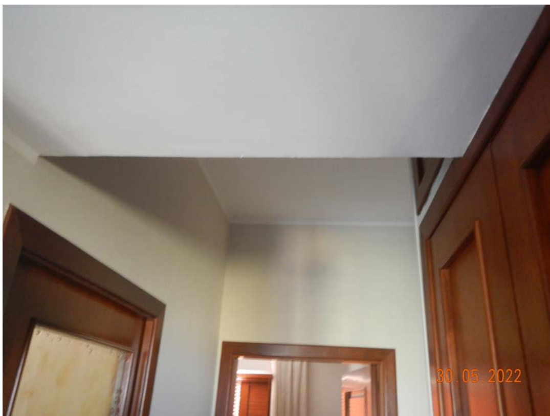
Disimpegno – camera a sinistra - Camera matrimoniale al centro – Armadio a muro
