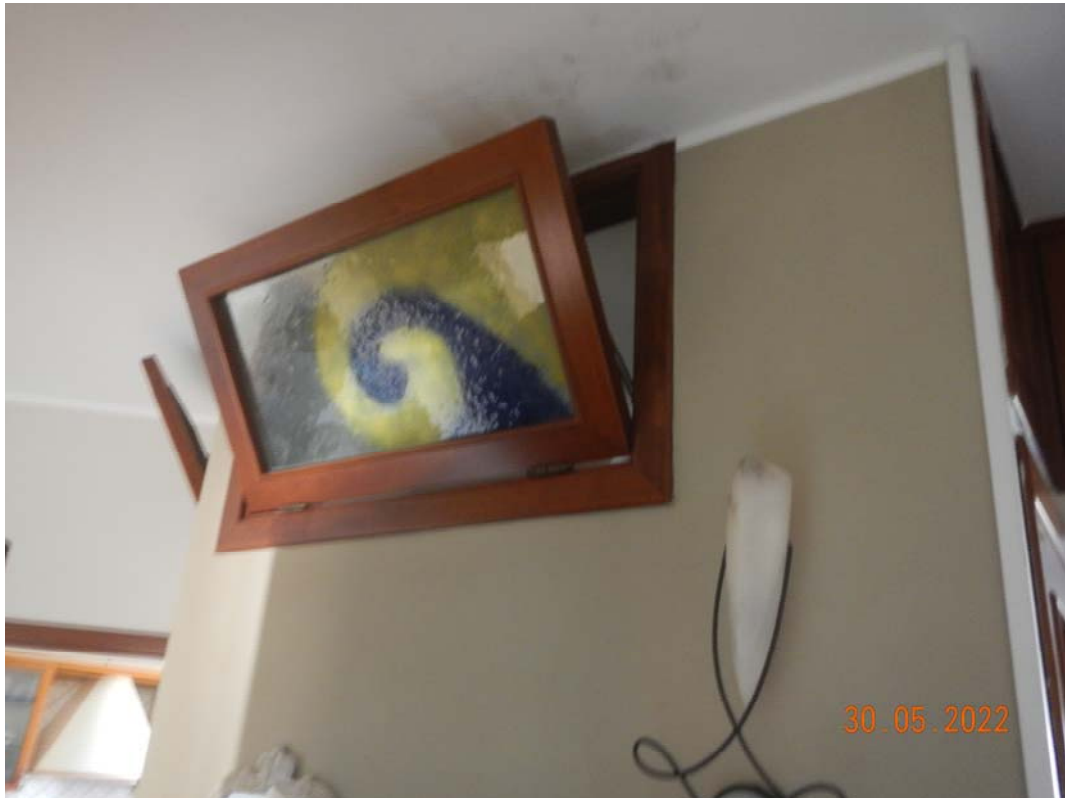
Disimpegno: aperture in legno e vetro comunicanti con il bagno di servizio
