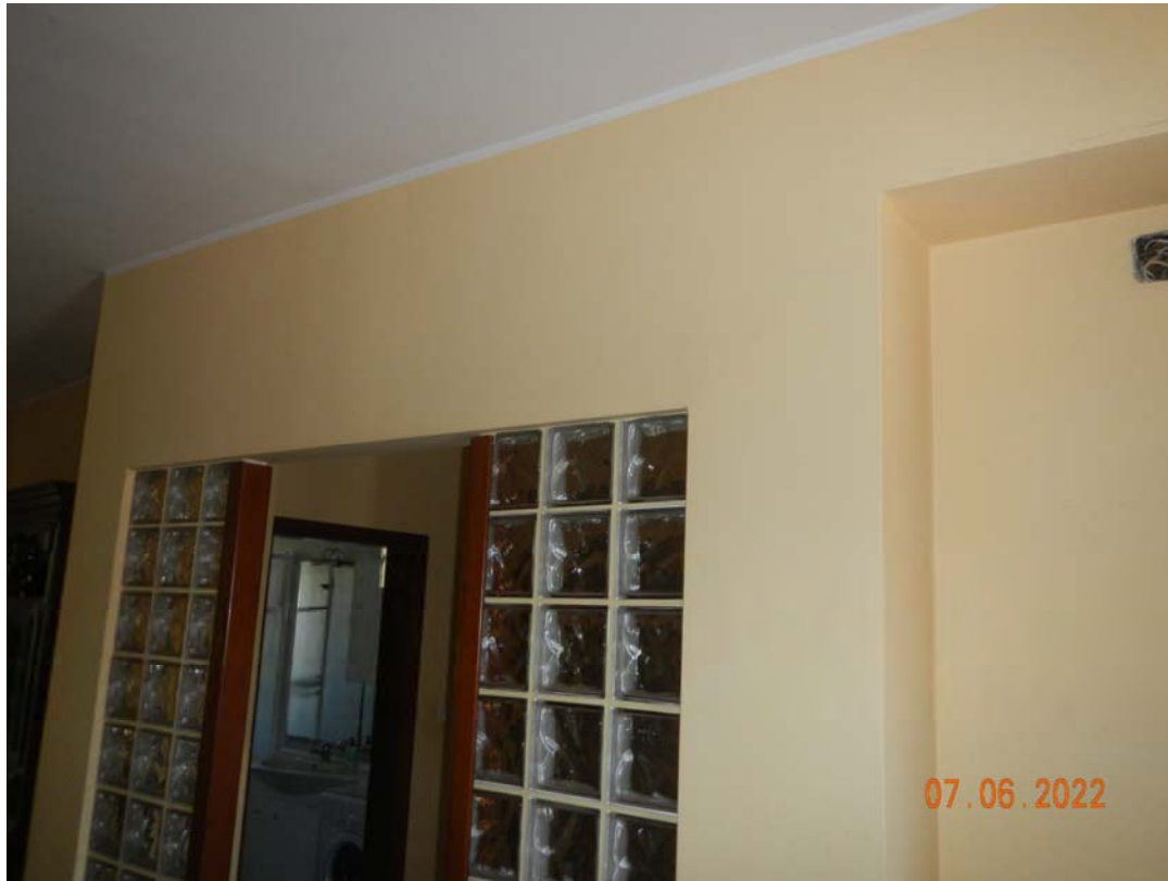
Parete in vetro-mattone di accesso alla Cucina
