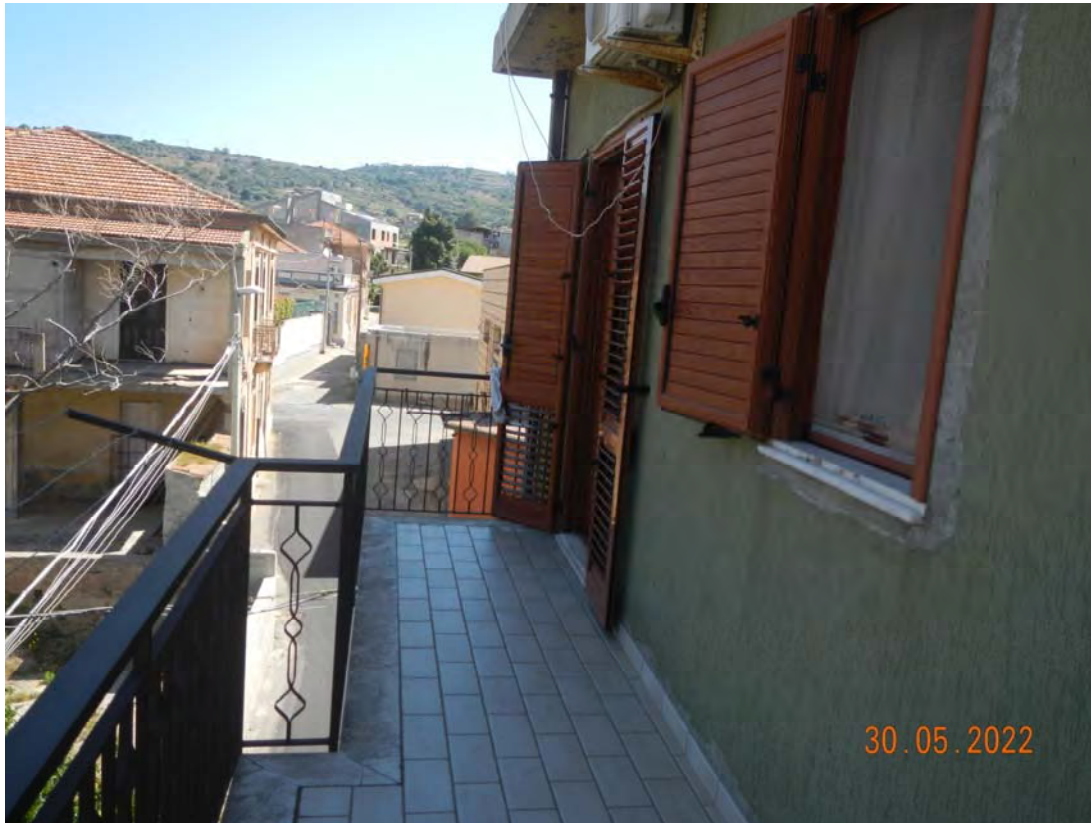
Balcone lato strada
