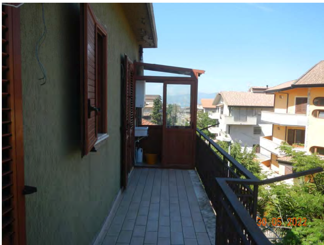
Balcone lato strada con lavatoio coperto realizzato in alluminio e vetro.
