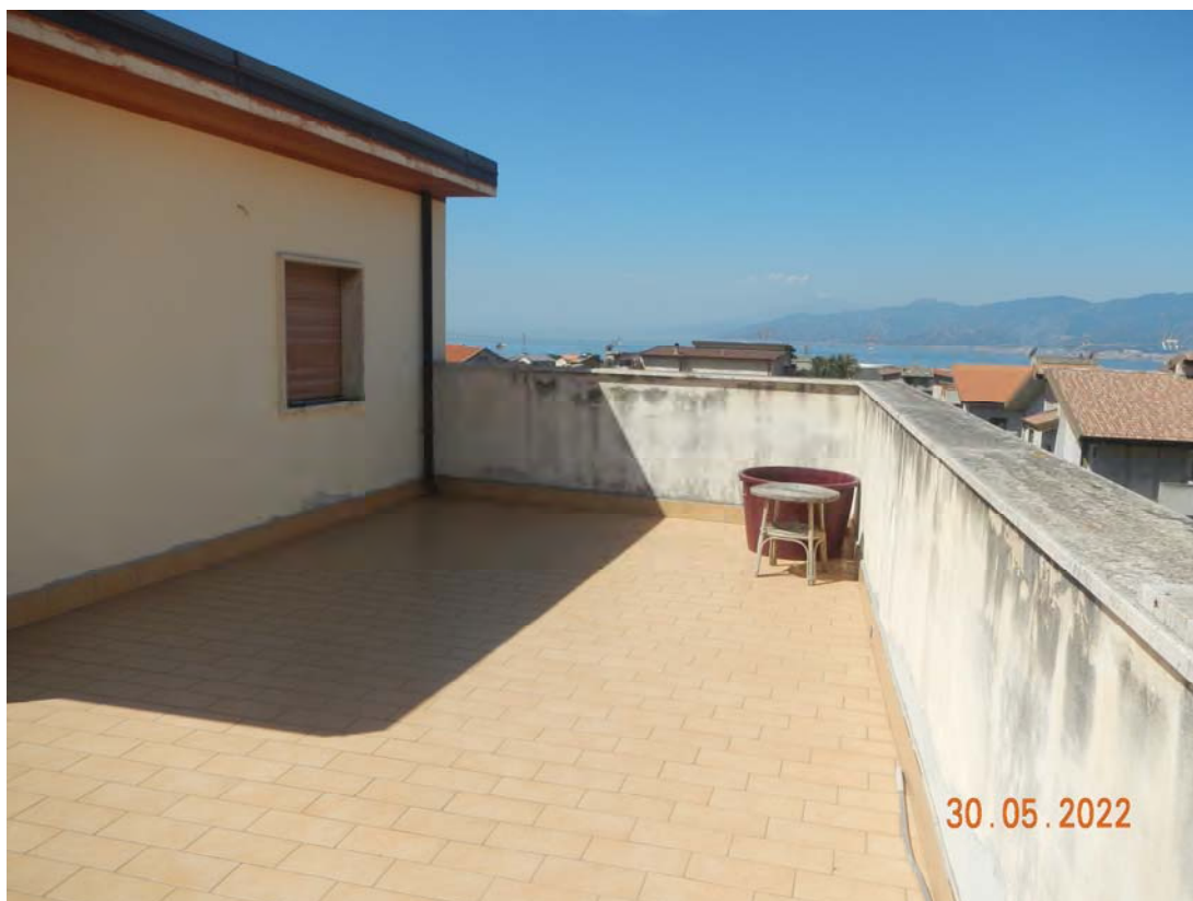
Parapetto e finestra corrispondente al locale deposito
